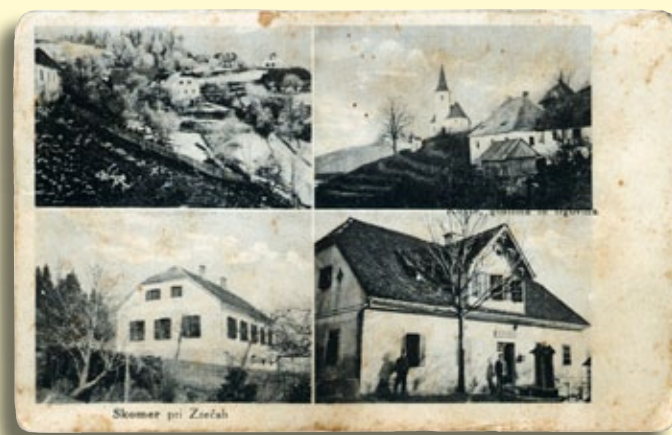
Skomarje – stavba OŠ levo spodaj (Razglednica z začetka 20. stoletja)
