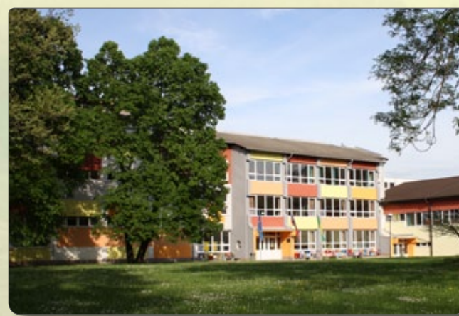
OŠ Zreče po sanaciji
