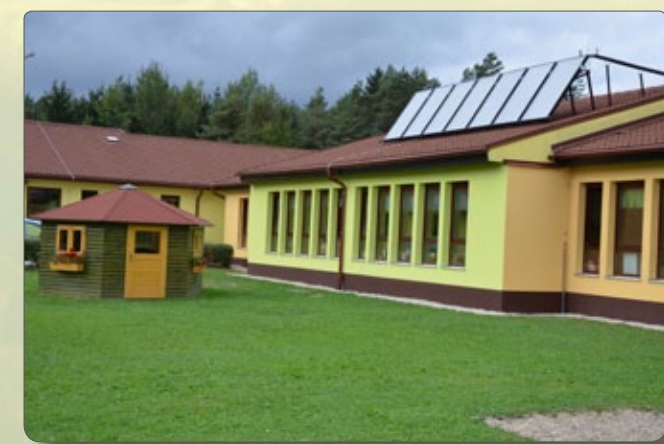
Vrtec Zreče po obnovi
