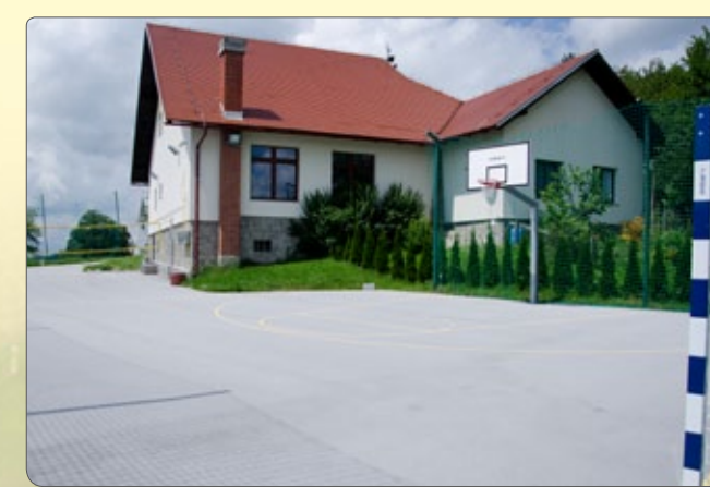
Obnovljeno igrišče na Skomarju
